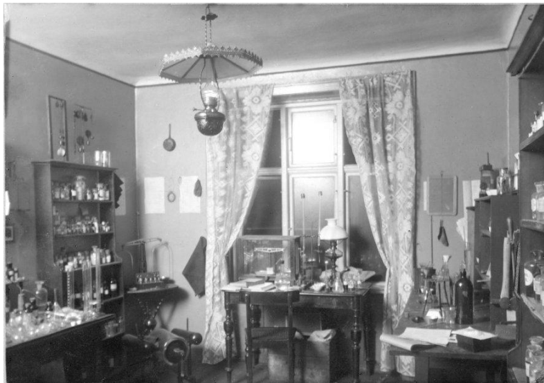
Kemisk oplysningskontor for Haandværkeres Laboratorium, Gothersgade 167 III
